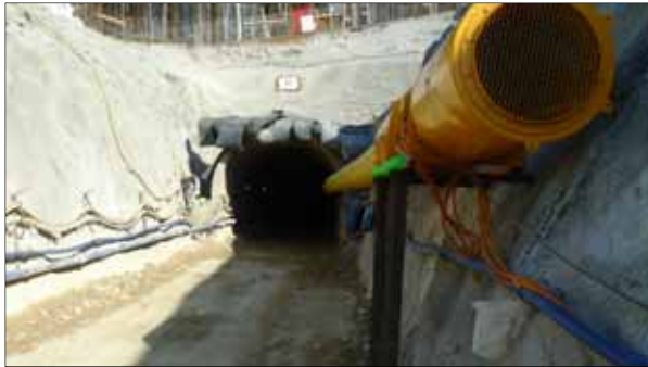
Abb. 1: Zugang zum Rettungsstollen (Foto: Yvonne Bleher).
